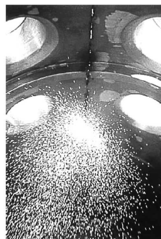
Рис. 2. Резка корпуса реактора кислородным резаком (Крымская АЭС)
