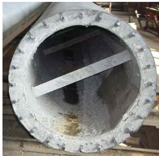
Рис. 6 – Зовнішній вигляд з торця на опору лінії електропередачання із 24 армуючими стрижнями
