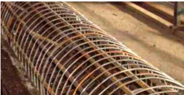
Рис. 1 – Металева арматура перед заповненням бетоном сумішшю
