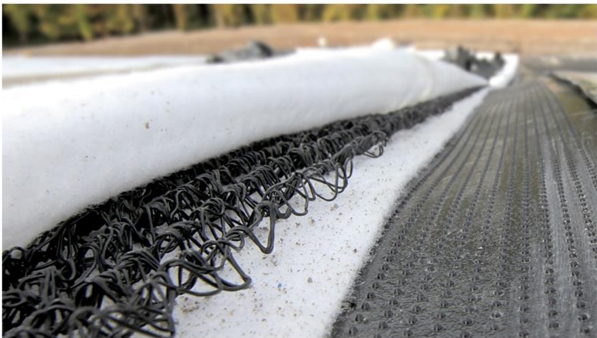
Рис. 4.18 – Схема пошарової укладки геосинтетичних матеріалів [77]
