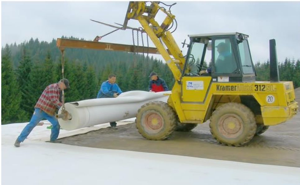
Рис. 4.17 – Укладання геосинтетичного матеріалу [77]
