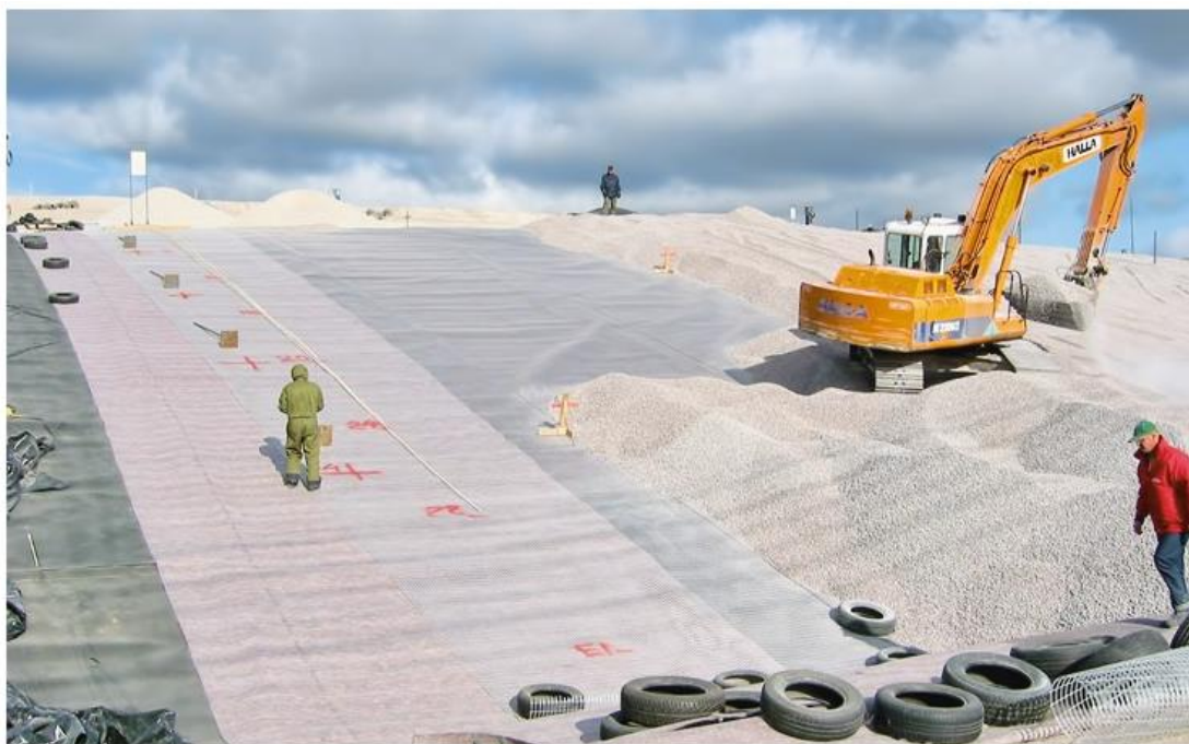
Рис. 4.15 – Укладка Бентофіксу[77]
