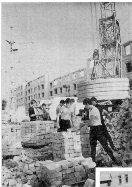
Идет работа на строительстве общежития № 8. Фото А. Дроздова (Одесский политехник. — 1984. — 12 жовтня, № 30 (1303))
