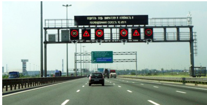
Рис. 1. Средства управления дорожным движением (информационные табло и знаки переменной информации)
