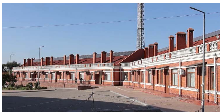
Рис. 2. Сонячні установки на даху інфекційної лікарні
