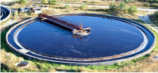
Рис. 4.4 – Радіальний відстійник
