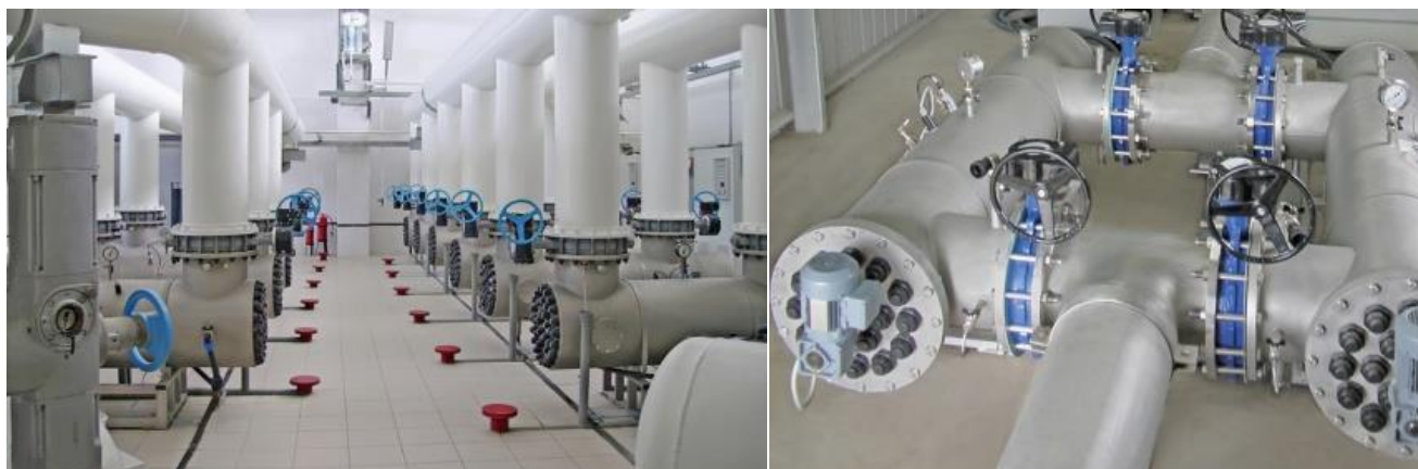
Рис. 5.8 – Установки для знезараження води в спосіб УФ-опромінювання
