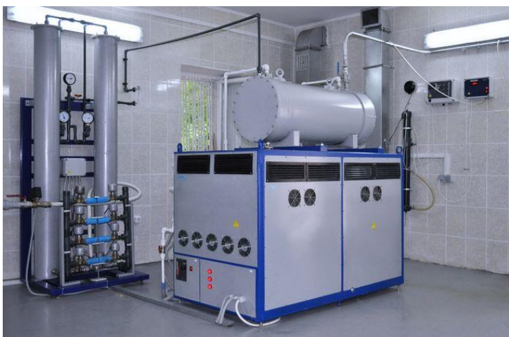
Рис. 5.4 – Установки для одержання озону та озонування води
