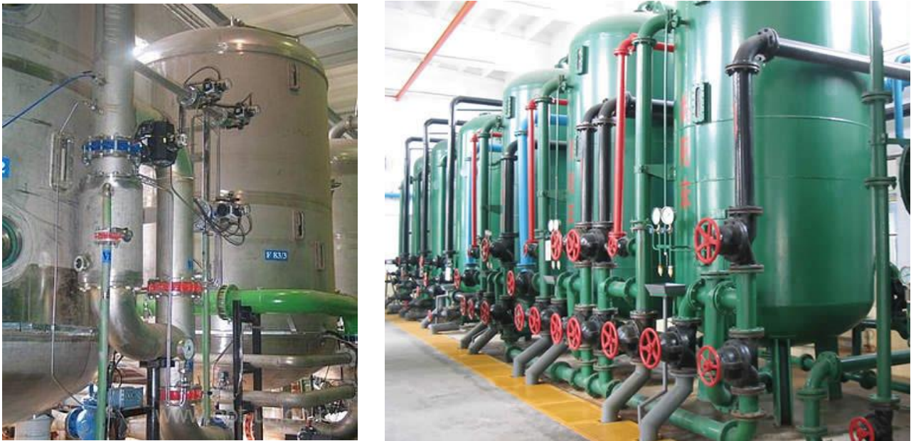
Рис. 6.7 – Фільтри для іонообмінного знесолення води
