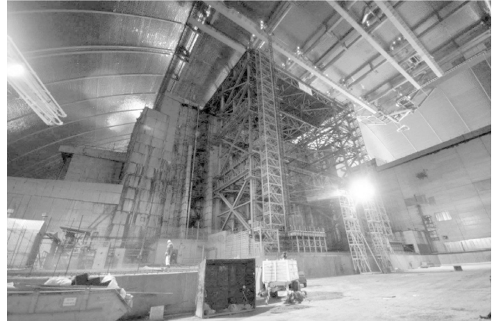
Рис. 2. Об'єкт «Укриття» після насування НБК
