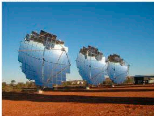
Рис. 5.2- Сонячна електростанція тарілкового типу
