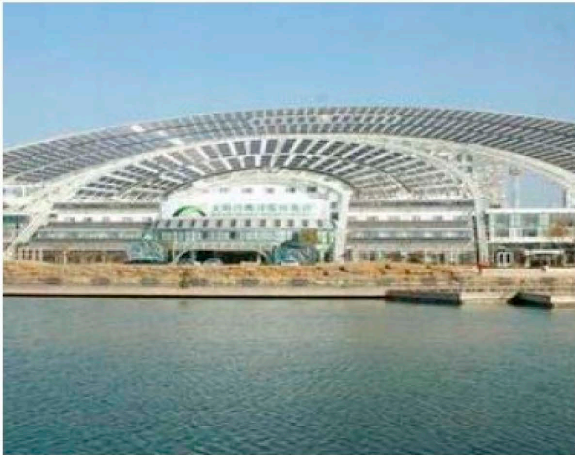
Рис 9.3 – Офісна будівля (Китай) Himin Solar
