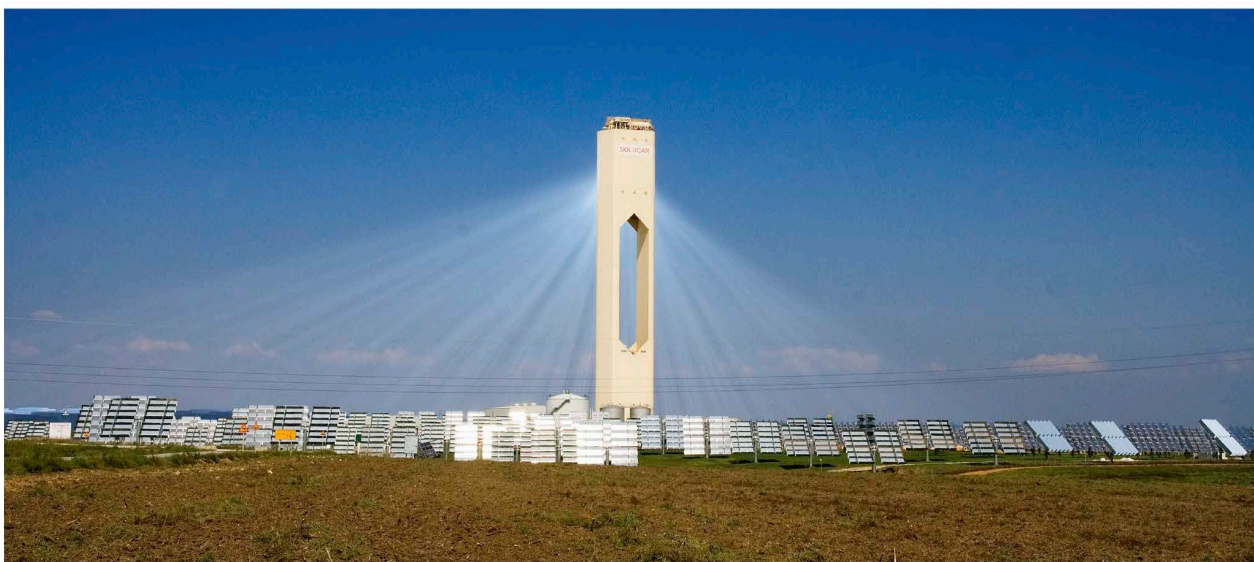
Рис. 5.3- Сонячна електростанція баштового типу
