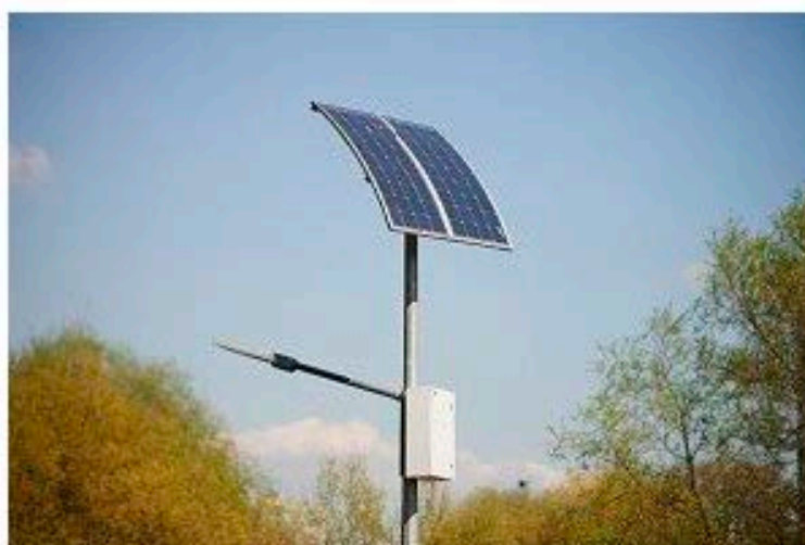
Рис. 6.2 - Автономне освітлення на сонячних батареях вулиць і доріг
