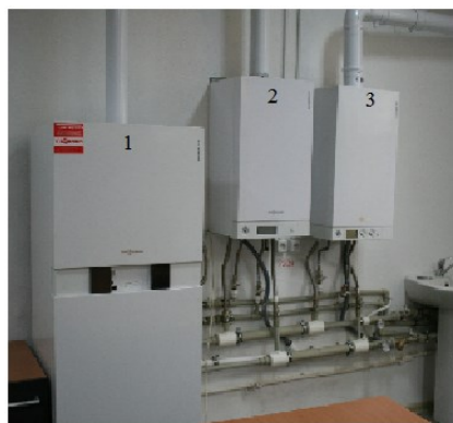
Рис 3 Газові котли
